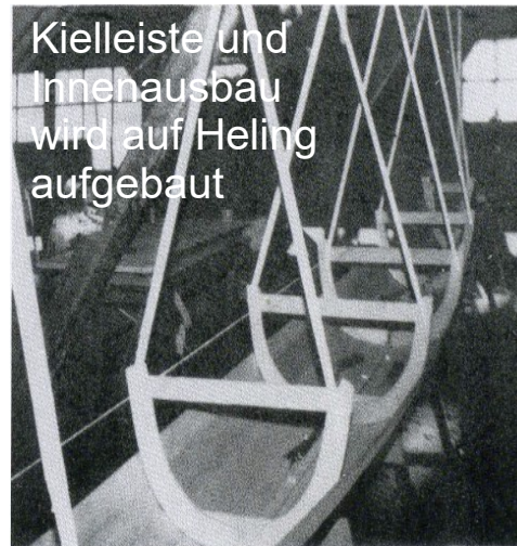
Abb.22: Bau einer geklinkerten Gig
